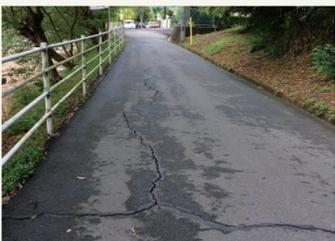
市内での道路損傷箇所(ひび割れ)の一例。長年の使用による劣化で、今後は市道、私道を問わず道路の修繕個所の発見と対応がいち早く求められる。
